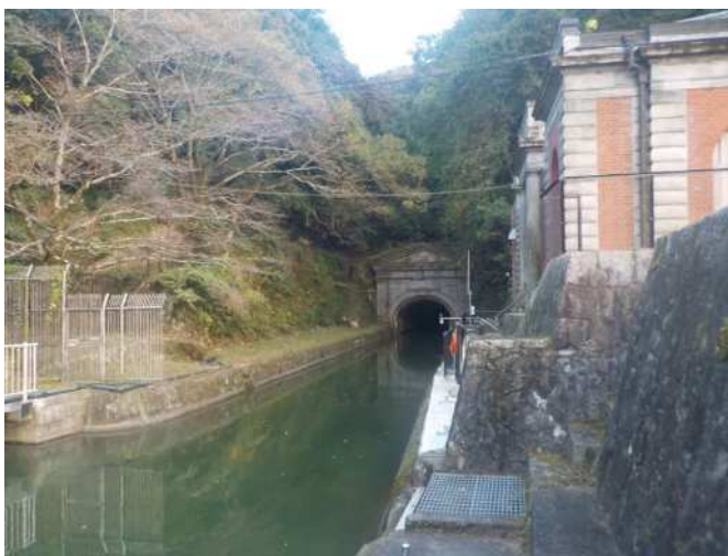
第三トンネル西口水路中継局(仮設) 蹴上
