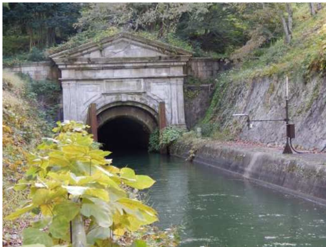
第一トンネル東口水路中継局
