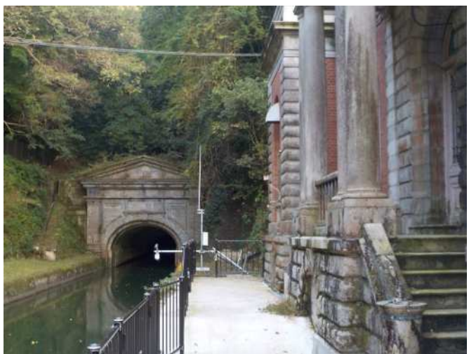
第三トンネル西口水路中継局(仮設)
