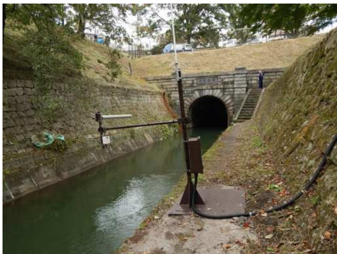
第一トンネル西口水路中継局
