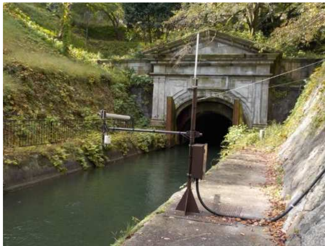
第一トンネル東口水路中継局
